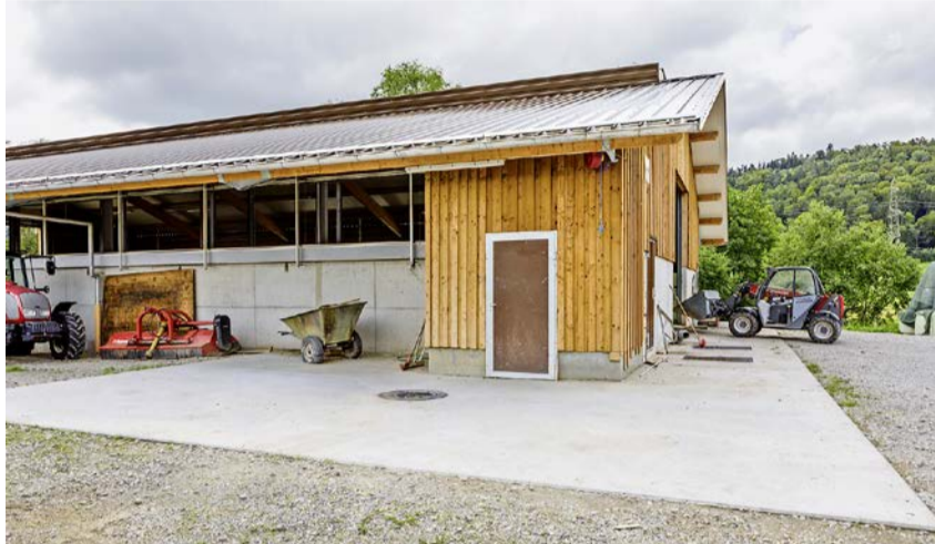
Gewässerschutzkonformer Neubau mit Waschplatz und Gülleentnahmestelle. Bild: AWEL
